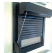
Secțiune rulou aplicat cu plasă
